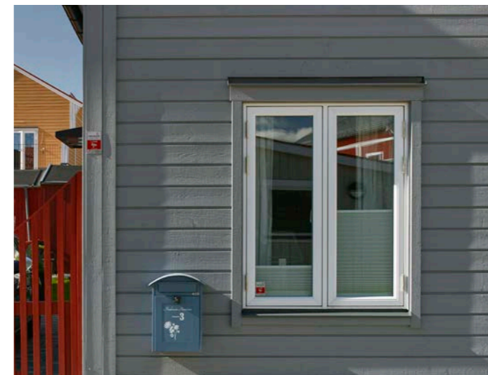
Tvåluftsfönster med fast mittpost i Hammaräng, Mariefred.
