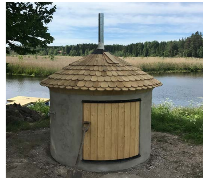
Pumphus som föreslås till infiltrationsdammar för bevattning av trädgårdsmästeriets odlingar. Gjord av brunnringar som isolerats och putsats och förses med ett tak av ekspån.
