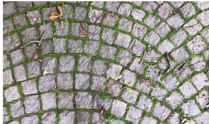
Hårdgjorda ytor vid Ryttarvägen för angöring och infarter skall utföras som gatsten med gräsfog.
